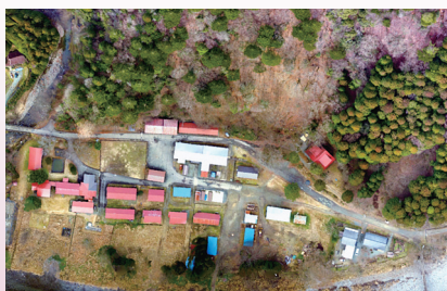
新年に雪が全くない構内の空撮 (芦生研究林)
