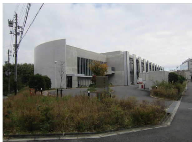
図 27 京大桂ベンチャープラザ南館 外観
