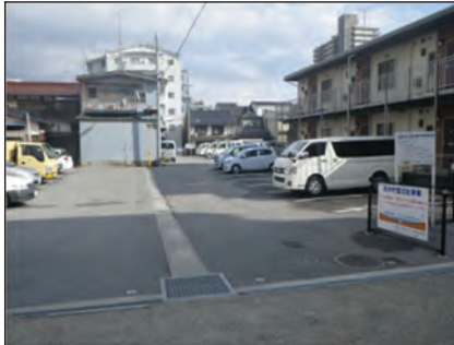
雨水貯留式公用車駐車場（彦根市）
