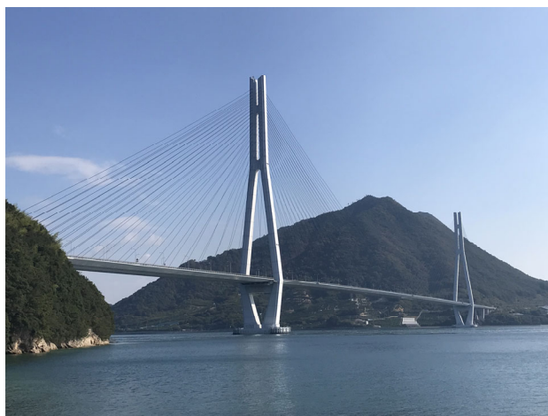
写真 1.1 我が国最長の斜張橋である多々羅大橋
