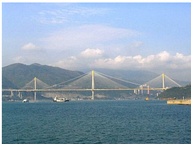
写真 1.4 Ting Kau Bridge[1-25]
