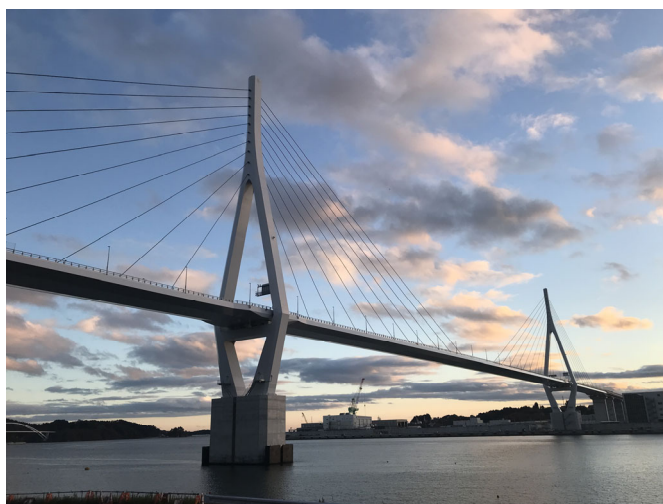
写真 1.14 危機耐性を考慮した気仙沼湾横断橋
