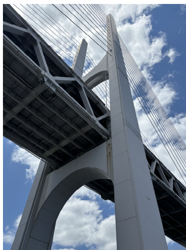
写真 1.12 隅切りを設けた東神戸大橋の主塔
