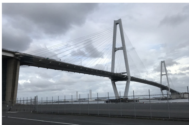
写真 1.13 面取りを設けた名港中央大橋の主塔
