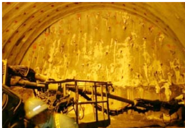
図-3 鏡ボルト打設後の切羽
