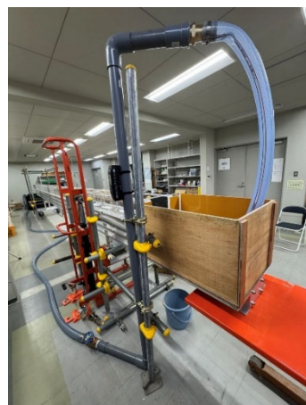
写真 4 給水部の設置
