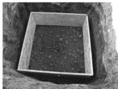
写真2.基盤用の型枠を設置
