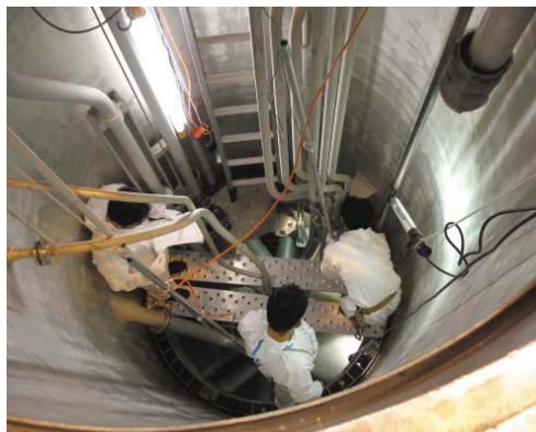
炉心タンク健全性調査（平成18年）
