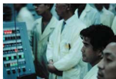
初臨界に近接中の制御室の様子（昭和39年）
