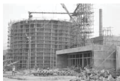
建設中のKUR原子炉建屋（昭和38年）
