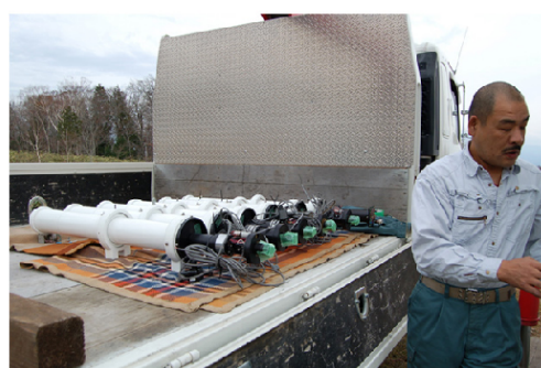
写真 2：飛騨天文台での FMT 解体作業
