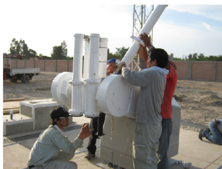
写真 3：ペルーでの FMT 組立作業
