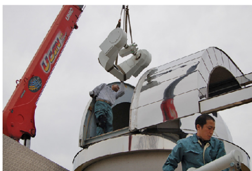
写真 1：飛騨天文台での FMT 解体作業
