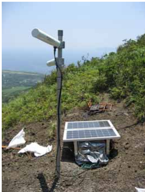
写真1 無線LAN中継点外観
