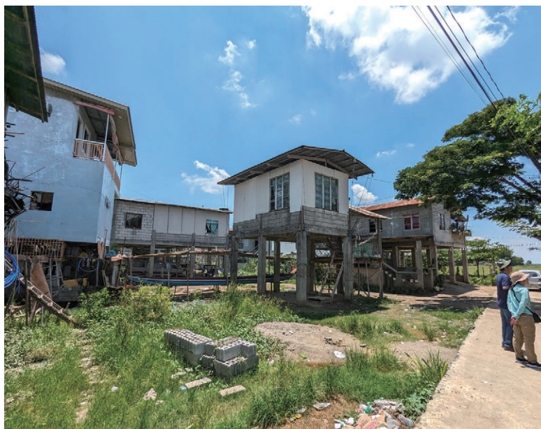
図1 フィリピン農村部の浸水常襲地における高床式の住居（筆者撮影）
