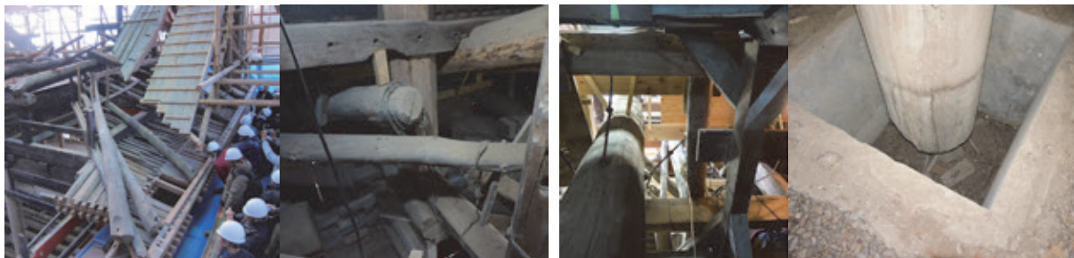
図8：桔木（左）と三重塔の心柱（右）；心柱は地盤に接せず浮いている。それぞれ簡易に固定される。
