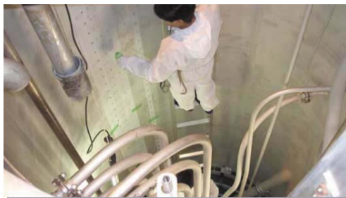
KUR炉心タンクの点検作業
