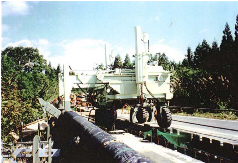
図 5.11 パイプ敷設クレーン (左にアウトリガー張出し中)
