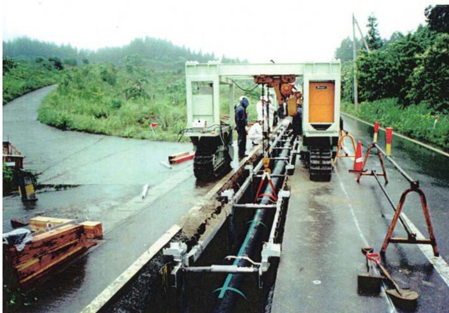
図 6.19 パイプ吊下しクレーン (吊り下げ作業中、上部切梁復旧作動直後)
