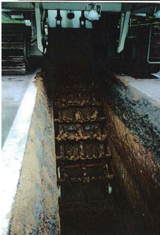
図 6.2 連続溝掘削機後方より （スラッターコンベアと走行用キ ャタピラー）
