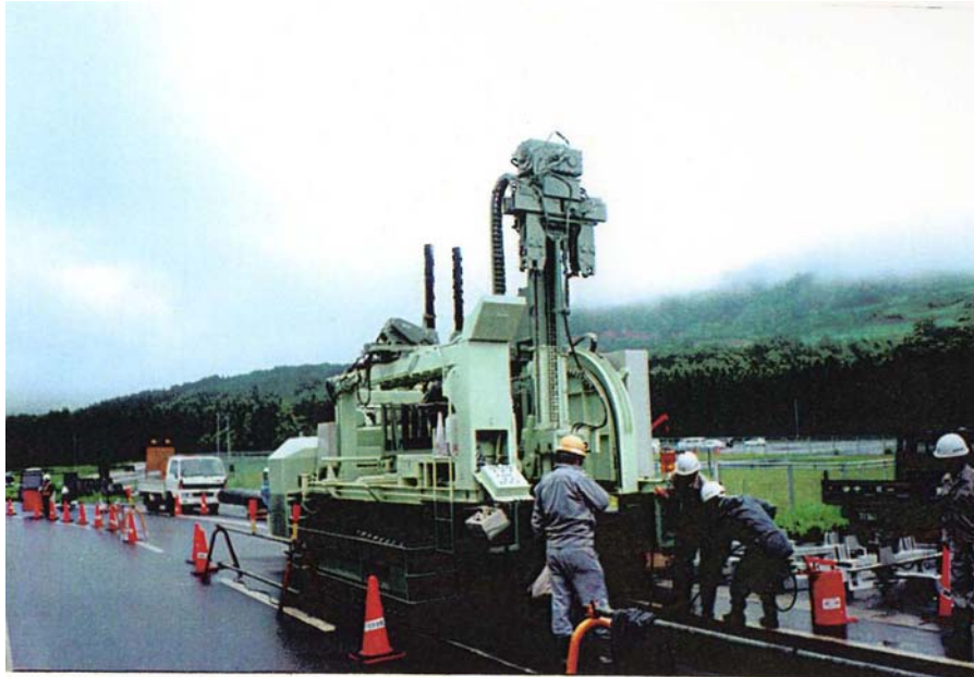
図 5.5 自動矢板打ち機（前面側）
