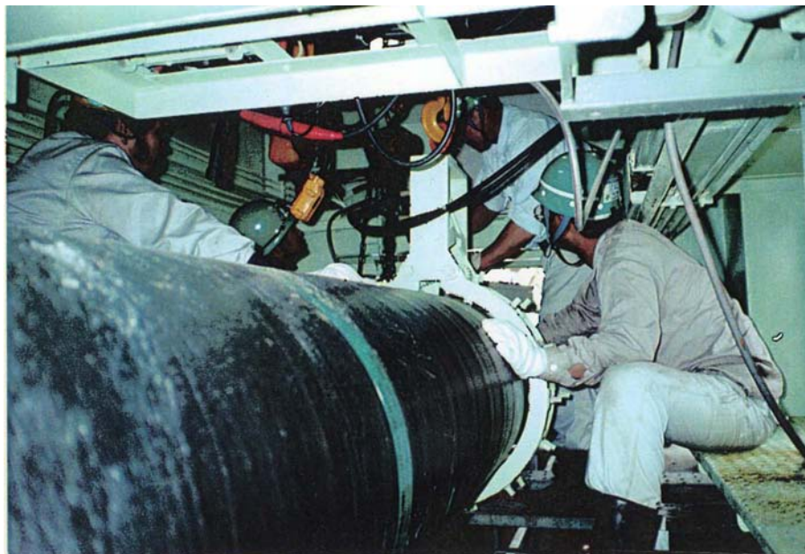
図 6.15 パイプ工作車 (パイプ芯出し作業、中央にパイプアウタークランプ)
