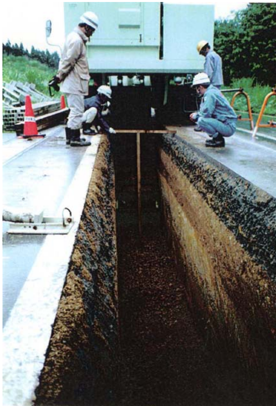
図 6.1 連続溝掘削機 溝掘削状況（掘削機後方より）
