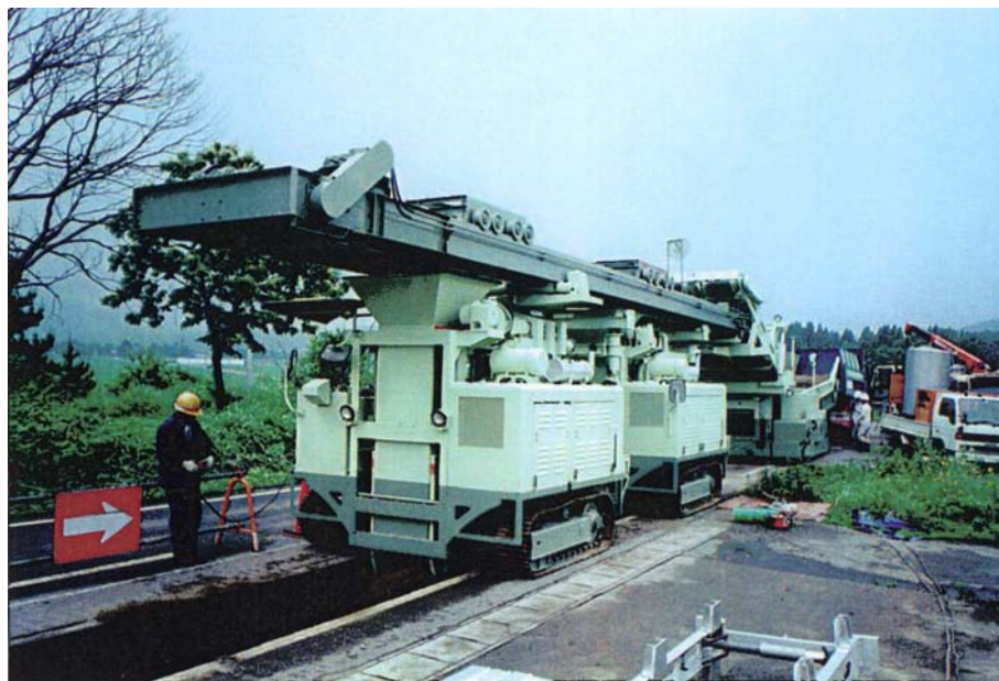
図 6.22 3機連結作業状況 (上部に11m2連ベルトコンベア)
