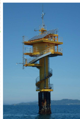
田辺中島高潮観測塔
