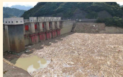
2011年紀伊半島水害時の流木 流入(橋山ダム)
