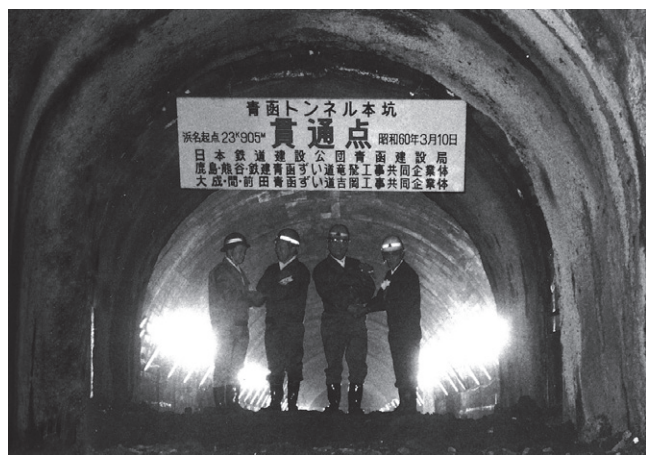
写真1 青函トンネル貫通(土木学会誌70巻4号、1985)
