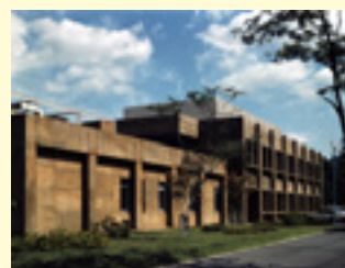
1981年竣工当時の核酸情報解析棟の外観。現在は、精密無機合成化学研究室と生体分子情報研究室が設置されている。
