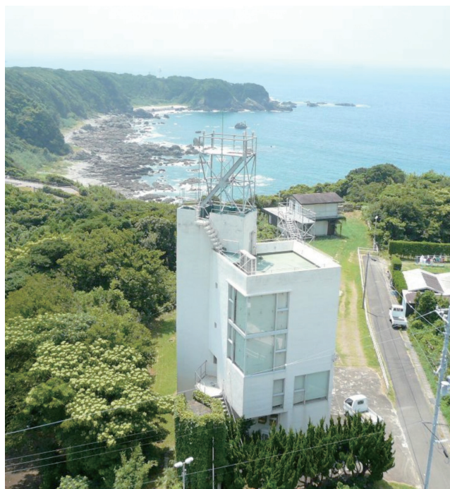
写真 1 潮岬風力実験所研究室本館
