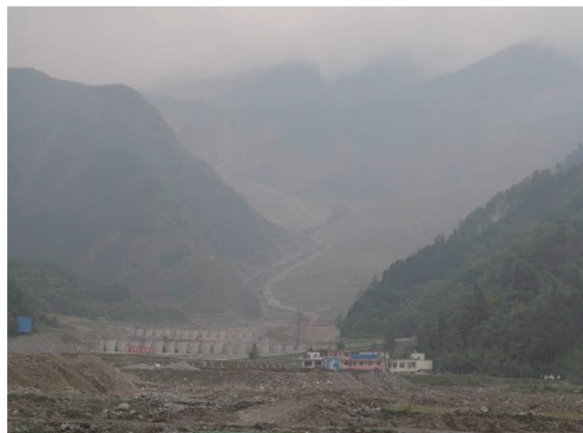
写真 7 銀杏溝の崩壊下部。流路工や床固め工が進められている。（2013 年 5 月 15 日撮影）
