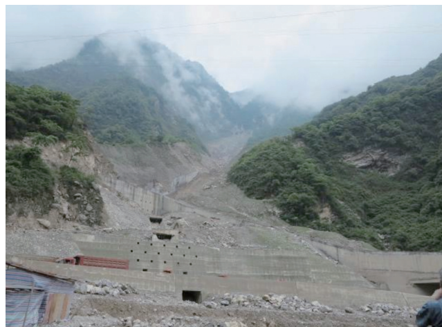
写真 5 清平の溪流対策。地震時に谷に堆積した土砂が下方の道路を繰り返し閉鎖してきた。初期の導流堤と砂防堰堤は破壊された。
