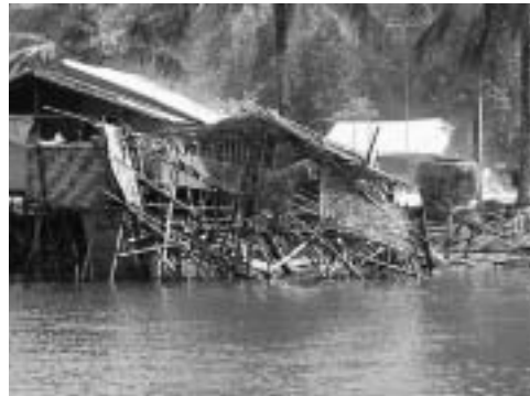
写真3 津波により倒壊した家屋
